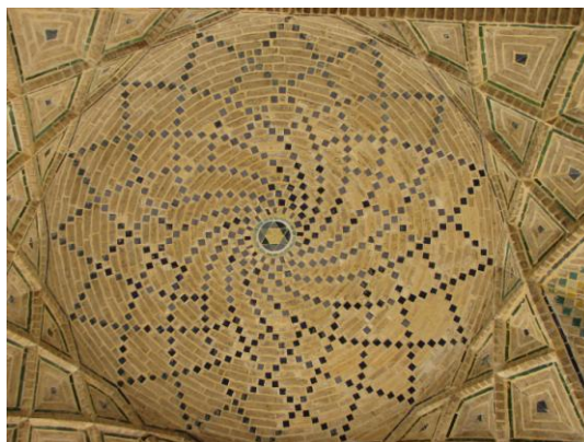
تزئینات آجرکاری سقف مسجد وکیل شیراز
