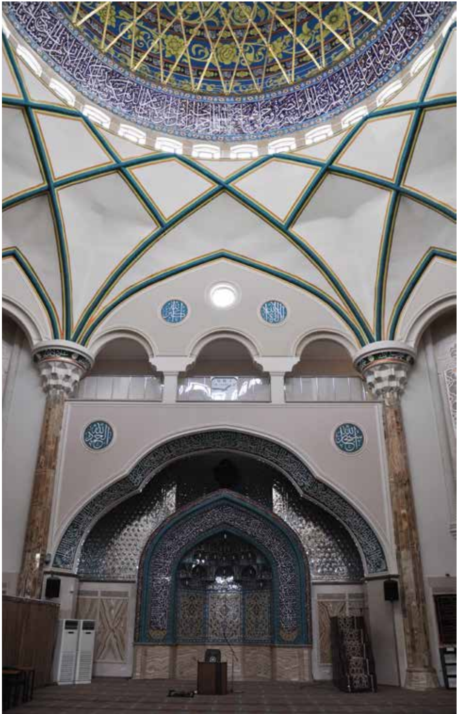
نحوه انتقال بار گنبد به پی در مسجد جامع امام صادق تهران
