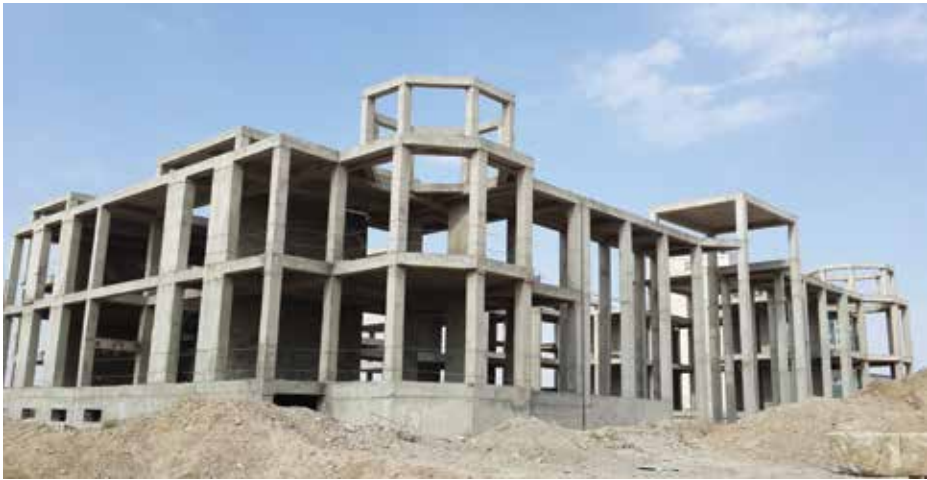
سازه بتنی مسجد فرودگاه امام خمینی (ره)
