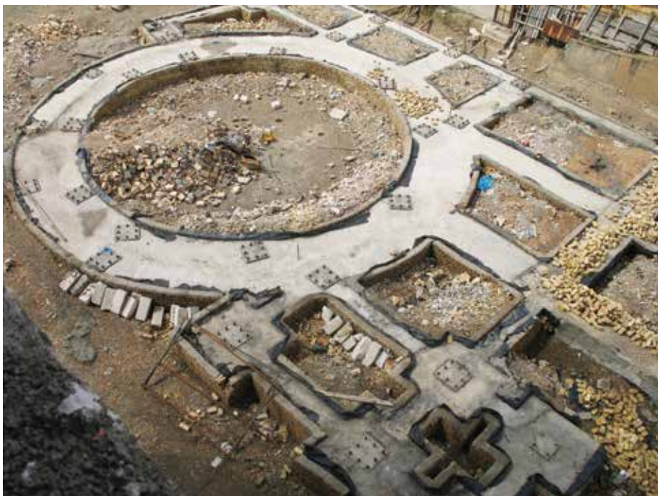
اجرای پی در نمازخانه مجتمع فرهنگی فضیلت تهران ۱۳۸۷
