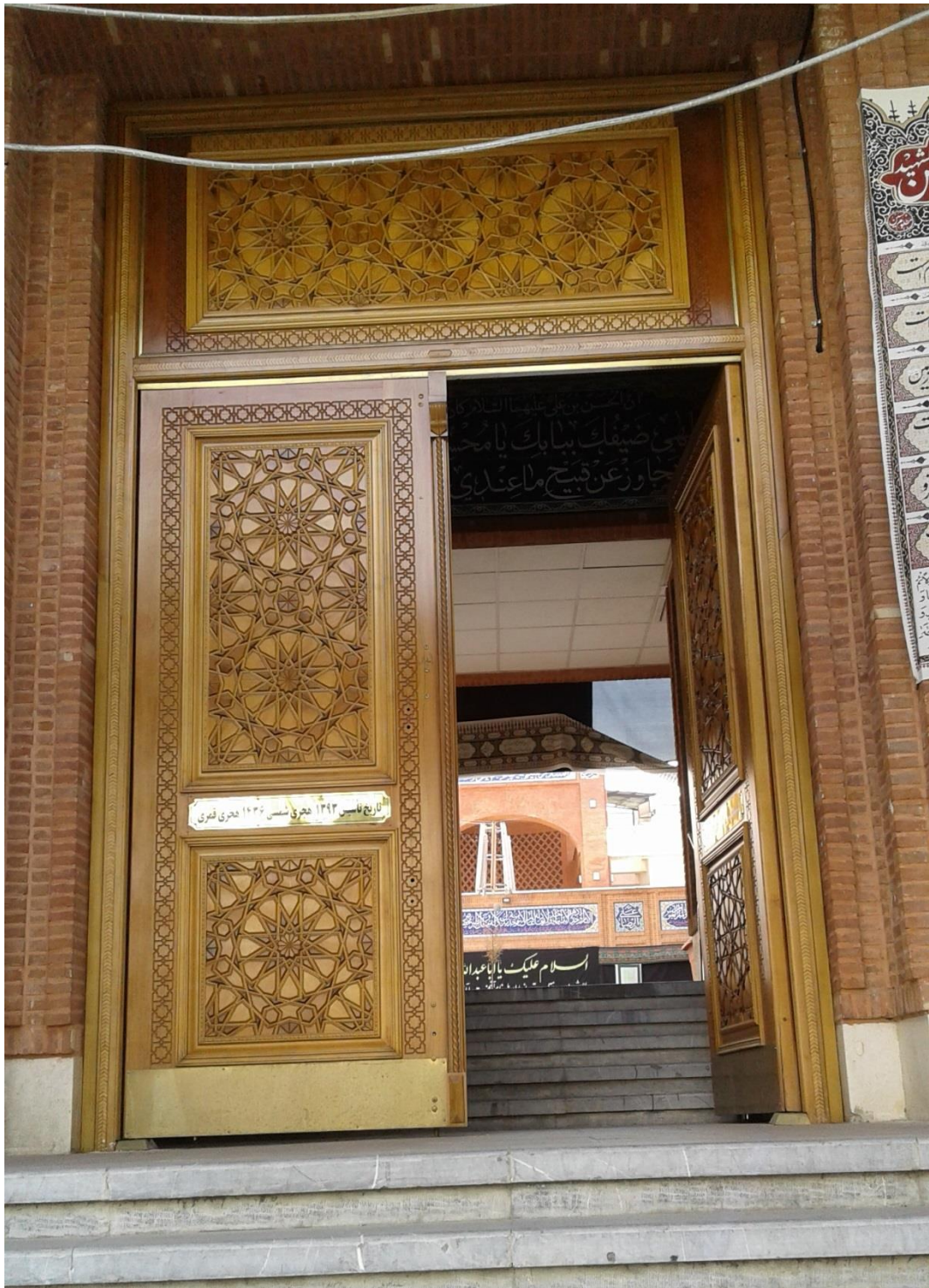
درب ورودی چوبی بدون حفاظ ( قابل مشتعل شدن )
