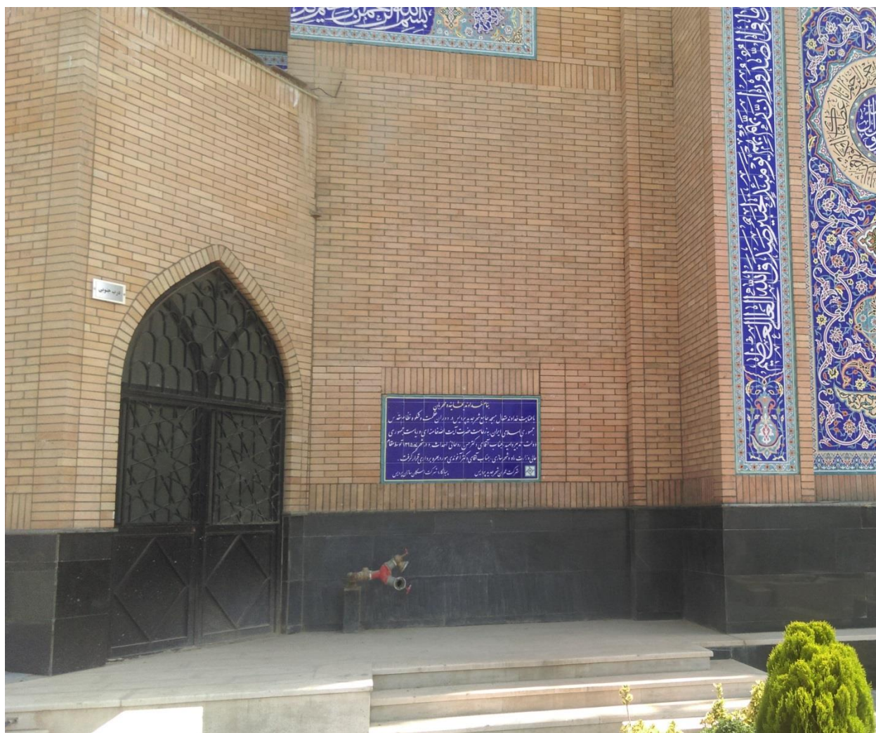
وجود شیر آتش نشانی کنار ورودی مسجد
