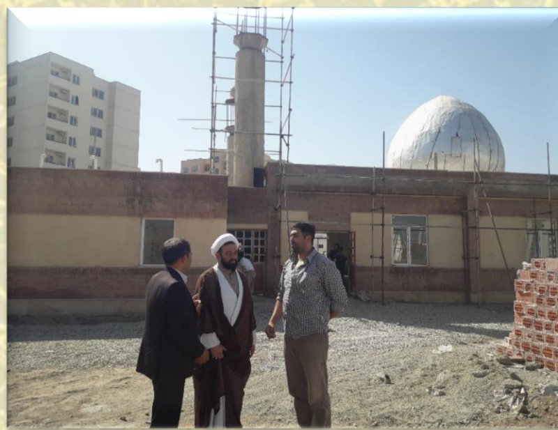
بازدید از مساجد در حال ساخت
